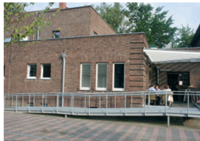
Eine Rampe verbindet den Platz mit Saal und Gaststätte
