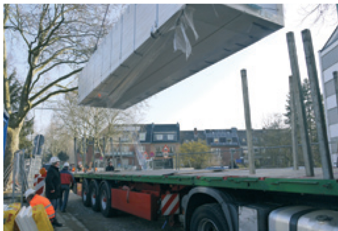
Mit einem Schwerlastwagen wurde der Glockenturm angeliefert
