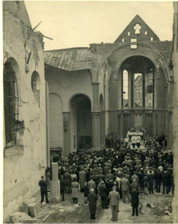
Bild 18: Gottesdienst in den Trümmern
